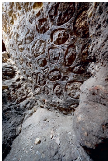
Figura 6. Cimentación del contrafuerte de la esquina noroeste de la torre. Foto: Israel Piña.
