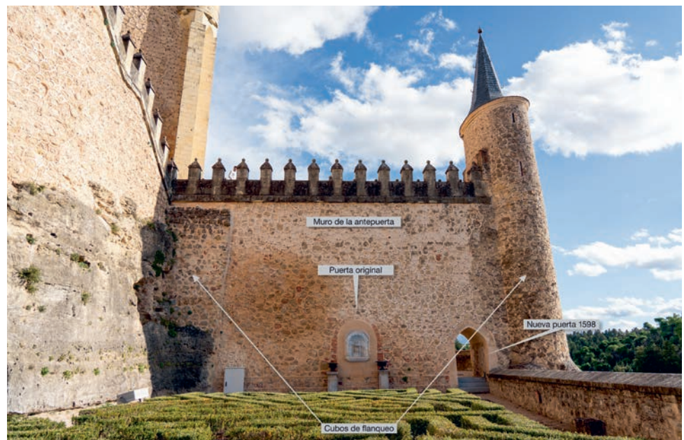
Figura 5. Muro y cubos de flanqueo de la terraza occidental. Foto: Israel Piña con rótulos de Óscar Silvestre.
