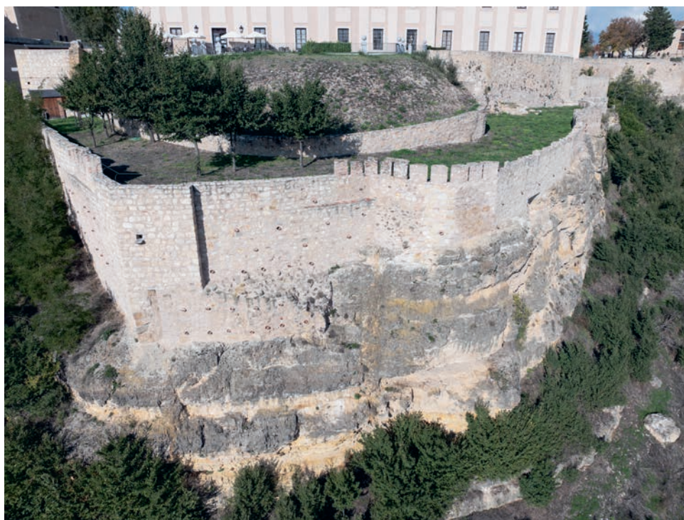
Figura 18. Detalle de la cimentación del saliente de la plazuela. Foto: Israel Piña.
