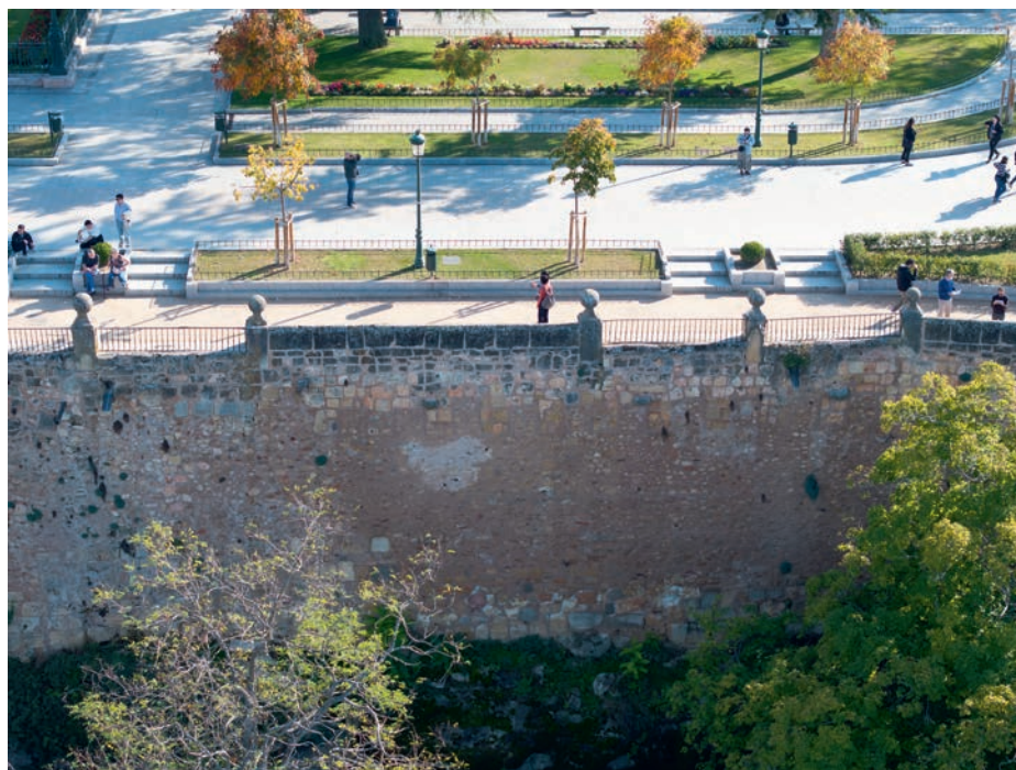
Figura 5. Almenas indicadas en el paramento de la muralla norte de la Plazuela. Foto: Israel Piña.
