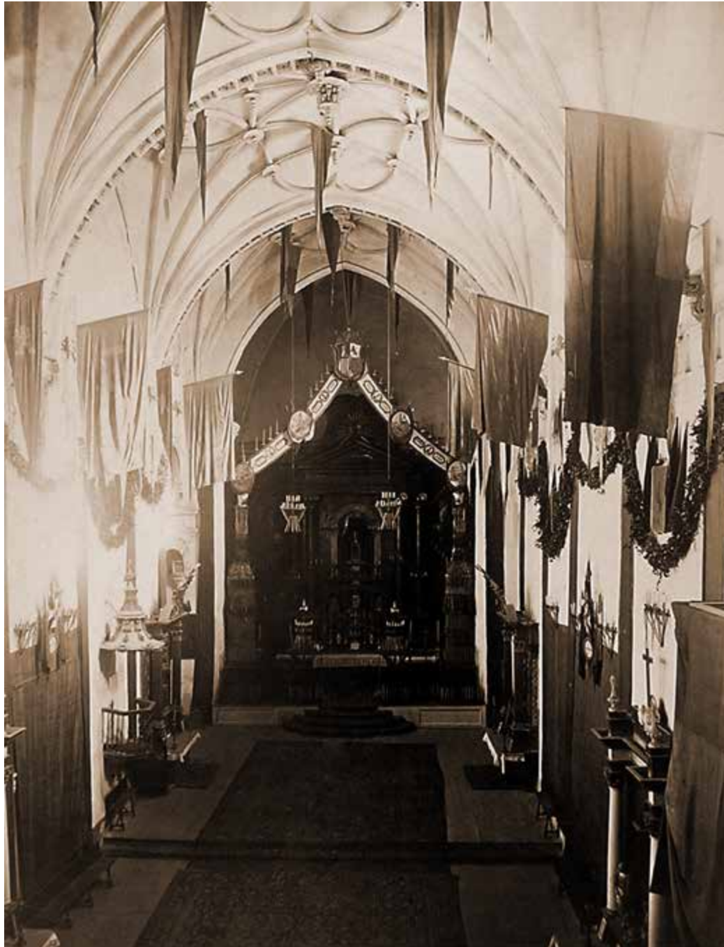
Interior de la iglesia de San Francisco de una única nave vista desde el coro. Al fondo el altar mayor, a la derecha se encontraba la entrada desde el claustro y a la izquierda las cuatro capillas privadas. Academia de Artillería, Biblioteca. Fot. 42-2.
