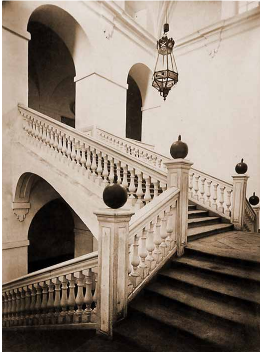
Escalera principal. Subida al pasillo de Honor. Las obras de rehabilitación se finalizaron en julio de 1890. Academia de Artillería, Biblioteca. Fot. 42-1.
