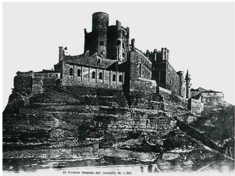
El Alcázar de Segovia después del incendio. Se puede observar el edificio del gimnasio con sus seis grandes ventanales.
