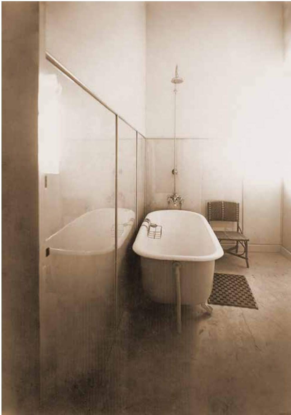
Cuarto de baño. Academia de Artillería, Biblioteca. Fot. 39-7.
