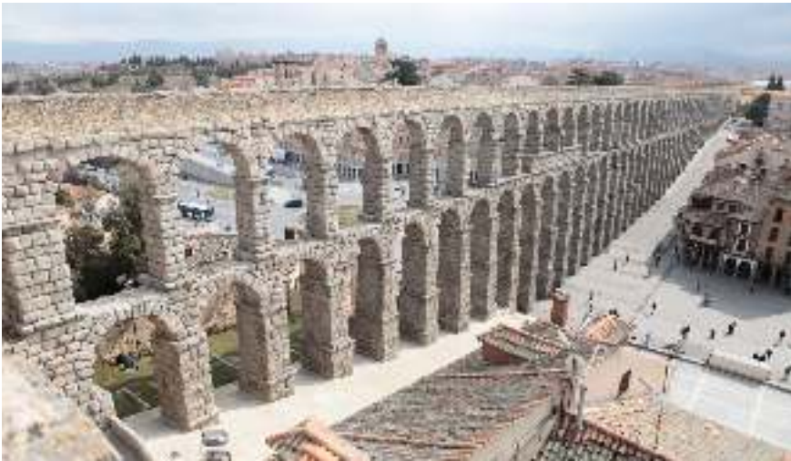
Perspectiva actual del Acueducto.
